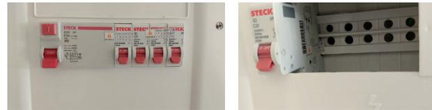
Disjuntores do quadro elétrico com lacres de proteção da construtora
